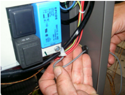
Bild 1: Rückwand durchführung, Kabelverlegung
