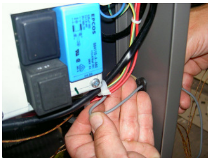
Photo 1: Passage dans la paroi arrière, installation des câbles
