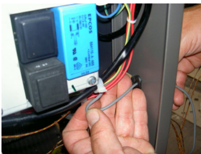
Figura 1: esecuzione pannello, posa cavi
